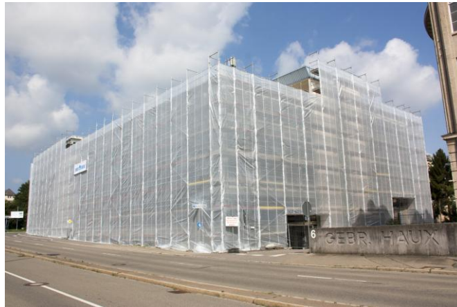
Abb. 8: Das während der Sanierung verhüllte Parkhaus am Bahnhof: eine kleine bauliche Randnotiz der Standortgeschichte, die im Stadtraum fast an Christos verpackte Architekturen erinnert.
