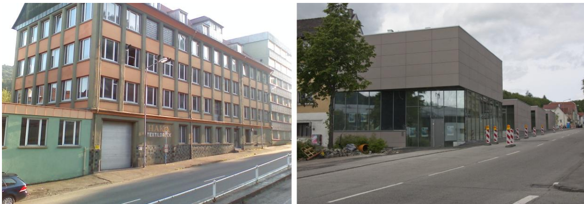
Abb. 39: Vom HAKO-Textildruckgebäude zur Technologiewerkstatt: der frühere Fabrikkomplex 2009 (links) und der Neubau kurz vor der Eröffnung 2015 (rechts). [26]
