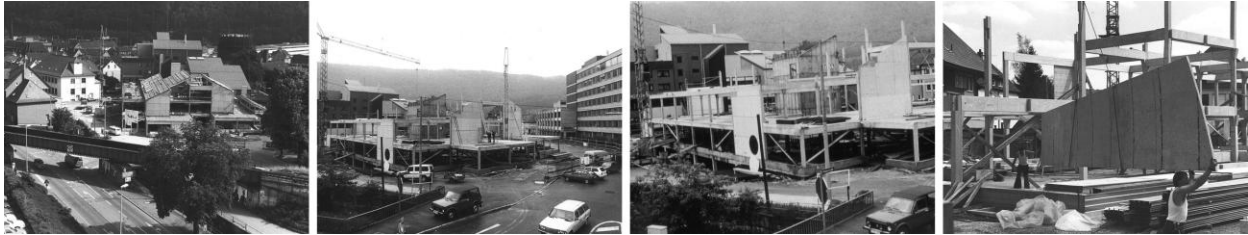
Abb. 3: Der Bau der Johannesstraße im Jahr 1988: vier Ansichten vom Rohbau im städtischen Umfeld bis zur Montage großformatiger Wandelemente.
